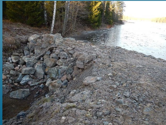
Torrlagt nedströms fångdamm
