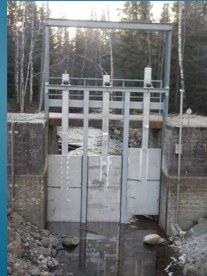
Nya spettluckor i rostfritt stål
