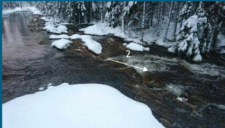
Dammkrönet vid kanalintaget överdämades (2). Vattenflödet rann ned i utskovskanalen
