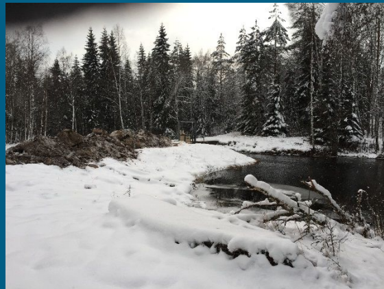
Fångdammsmassor upplagda, klara att läggas ut uppströms dammen
