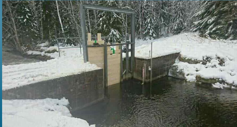
Temporära träluckor isatta vid regleringsdammen Södra Hörken
