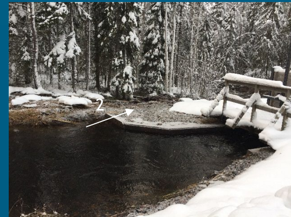
Dammkrön vid kanalintaget överdämades (2)
