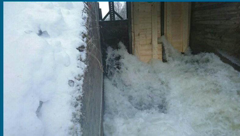
Temporära luckor minskar flödet som blir kontrollerbart
