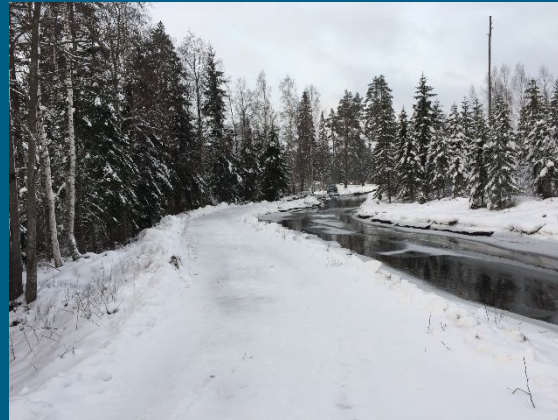
Dammkrönet längs kanalinvallningen klarade sig. Vattenytan nära dammkrönet
